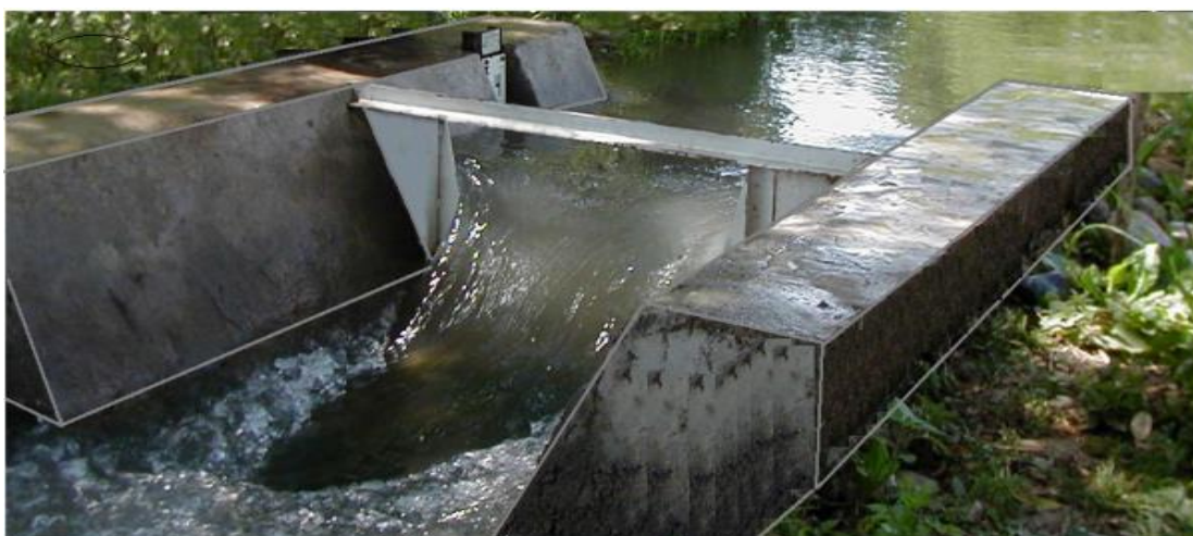
4-nji surat. Trapesiýa şekilli enjamyň suw mukdaryny ölçýji bent gädiginiň görnüşi
