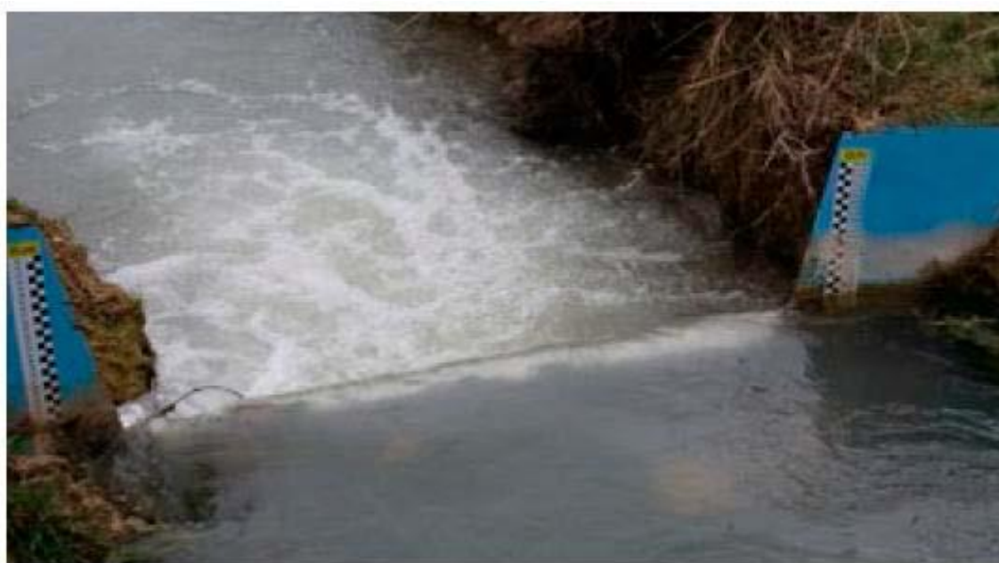
1-nji surat. Kämilleşdirilen suw ölçeýji enjamyň (wodosliwiň) ýapda goýulan görnüşi
