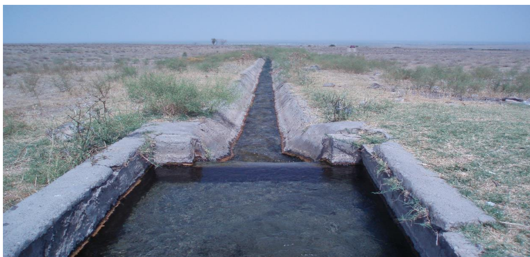
5-nji surat. Guýma beton örtüklü nowhanada suw mukdaryny ölçýän ýuka diwarly trapesiýa şekilli enjamyň bent gädiginiň görnüşi
